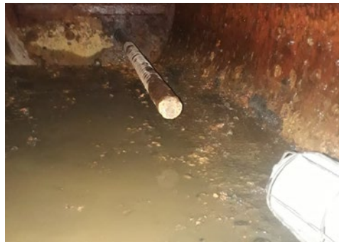
TANQUE ELEVADO POR DENTRO.
